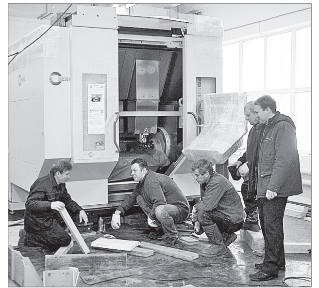
Монтажники цеха 50 завершают установку станка
